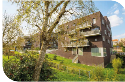
Bornéo Nantes 55 logements
