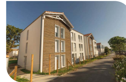
Le Moitessier Pornic 49 logements Résidence pour Jeunes Actifs
